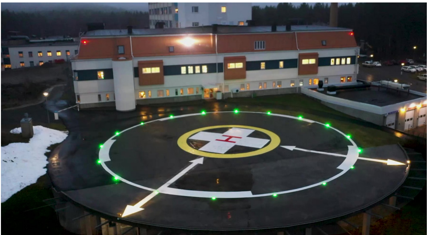
Infällda heliport armaturer på Lycksele lasarett
